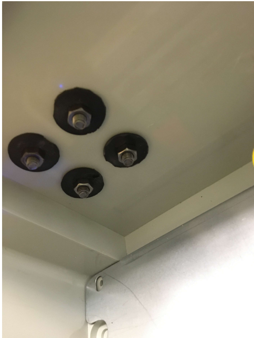
شکل ۵ نصب بادسنج بوسیله واشرهای پلاستیکی، داخل تابلو
