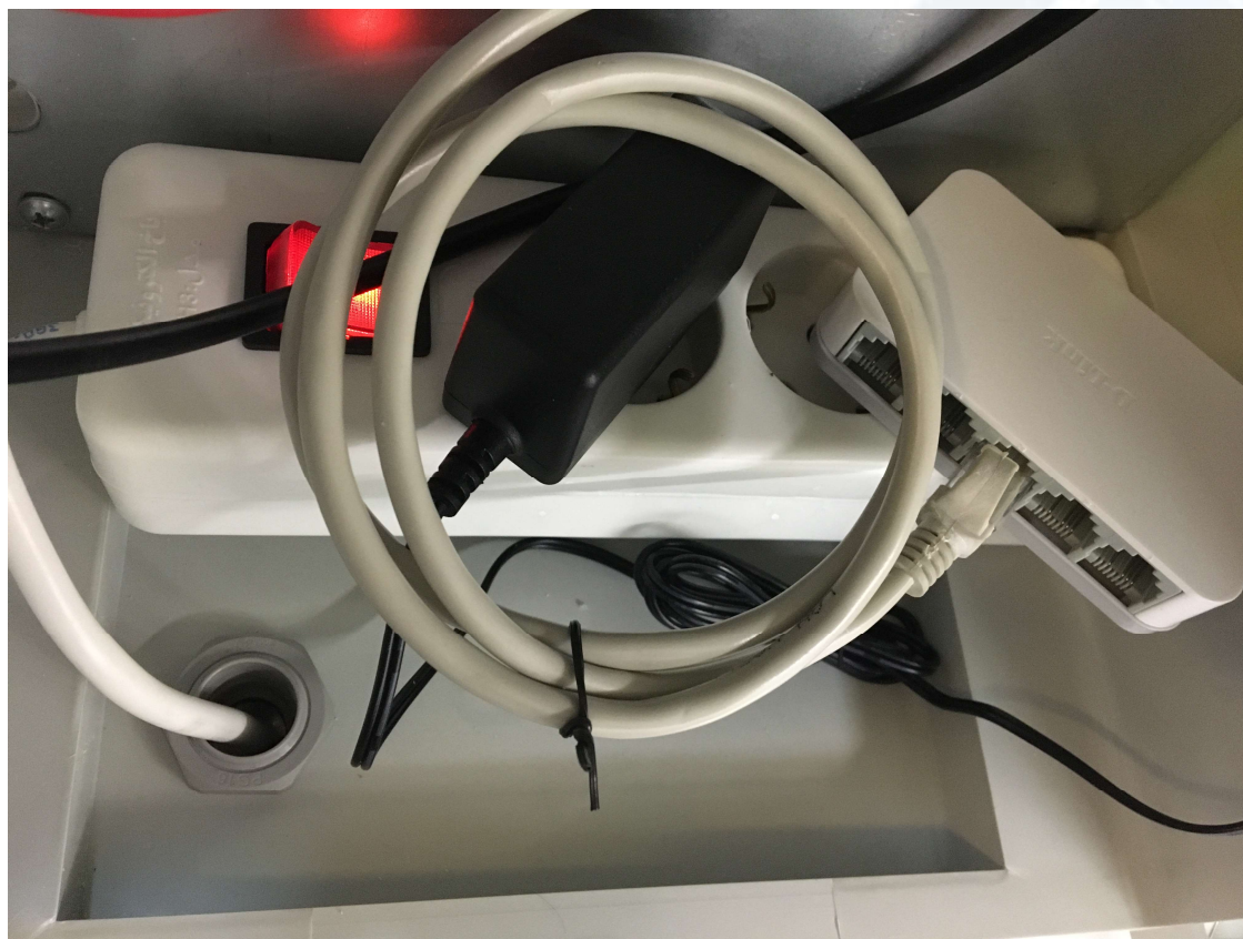
شکل ۷ گلند PG-16 جهت زیر تابلو، جهت ورود کابل برق و شبکه به تابلو
